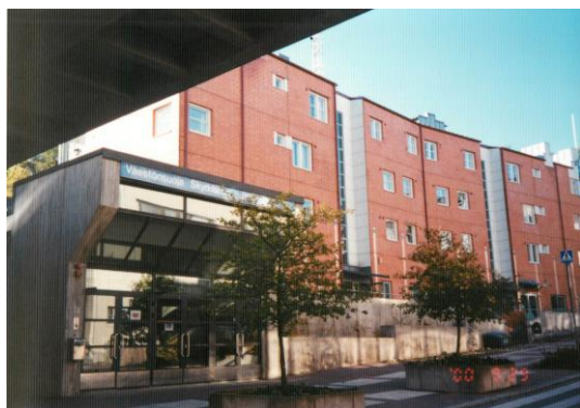
写真-4 シェルターの入口
