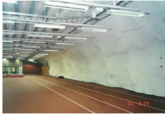
写真-7 シェルター内の走行レーン
